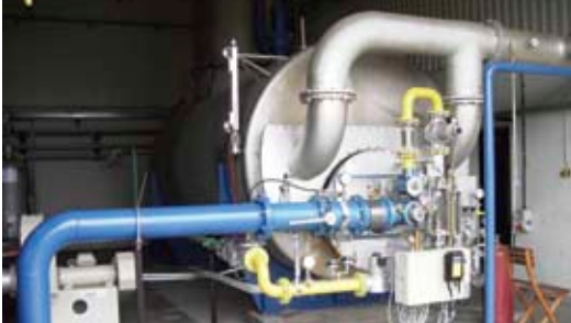
Edelstahl-Reboiler mit Spezial-Brenner für Erdgas (System BUSE ERZ 0500)
